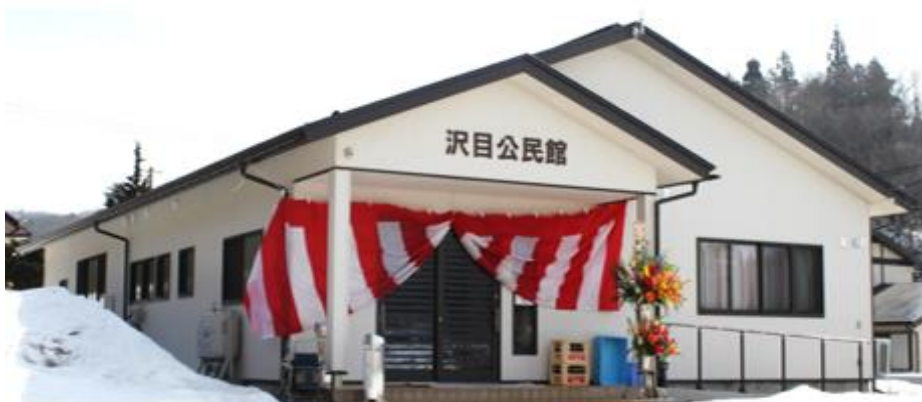
新築された沢目公民館
